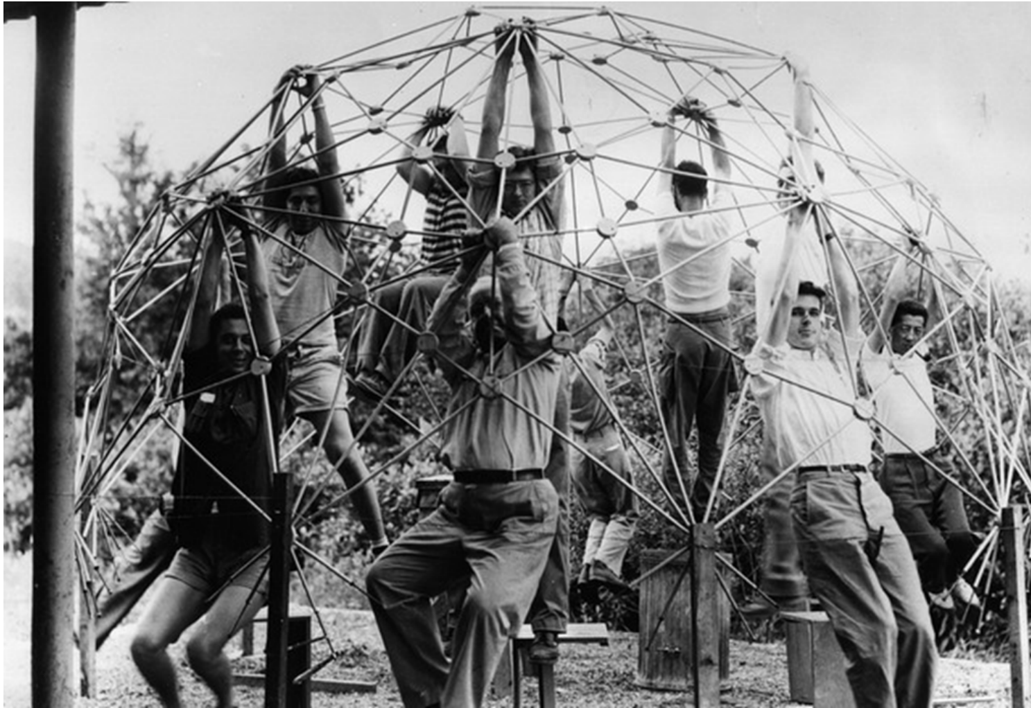
Alumnos construyendo la cúpula geodésica Dome, Black-Mountain-College.(K. Snelso)
